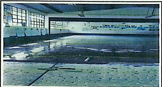
Fotografía 4: Avance en la instalación de piso cerámico en el primer módulo.
