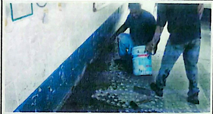
Fotografía 2: Instalación de piso cerámico en uno de los corredores en uno de los módulos.
